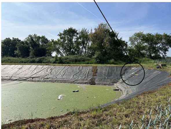
Photo 7 – Bassin de gestion des eaux pluviales dimensionné pour le confinement des eaux d'extinction
